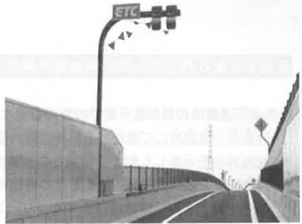
「ETCフリーフローアンテナ」とは料金所のない入口または出口に設置された **ETC** マークの看板表示があるETCアンテナです。
